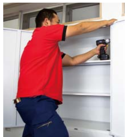
施工状況 (書庫)
