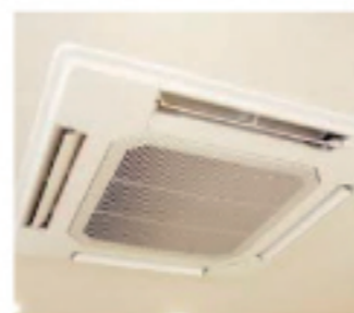
エアコン工事(業務用)
